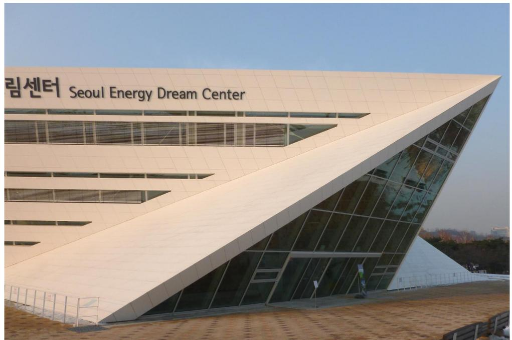
Bild 3: Keilförmige Vordächer verlaufen schräg über die Fassade. Sie dienen als Witterungs- und Sonnenschutz.
