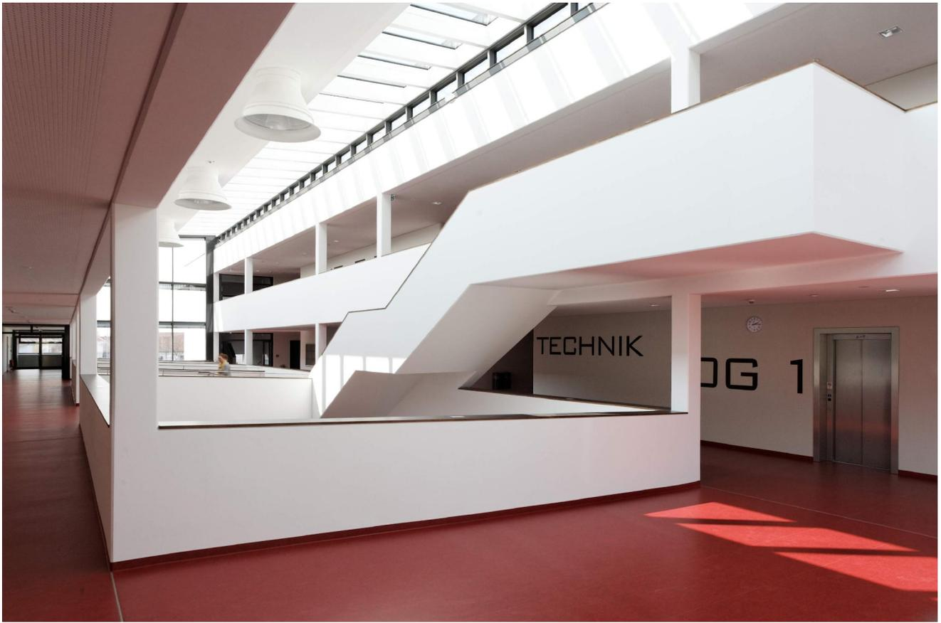
Bild 6: Die massive Speichermasse im Gebäudeinneren bewährt sich als Hauptvorteil für den sommerlichen Überhitzungsschutz.
