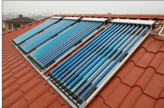
Bild 2: Thermische Solaranlage auf dem Dach eines Gebäudes.
